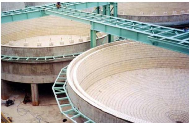
上图：带有附加陶瓷保护的涂层污水分离器。
