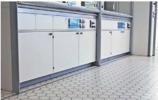
上图：瓷砖铺设在耐化学腐蚀的密封层上，使用等效的合成树脂砂浆和灌浆。
