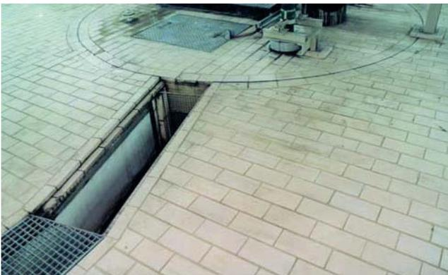
上图：热塑性水槽机械地锚固到地基中，具有用于连接到瓷和砖工业地面的特殊详细解决方案。
