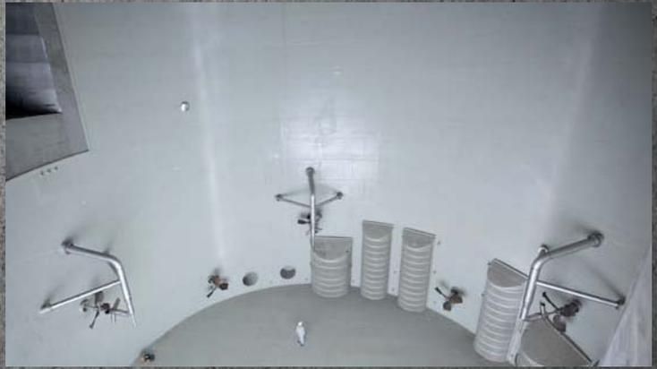
上图：混凝土/ BEKAPLAST™烟道气脱硫设备的内部视图。
